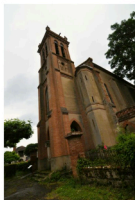
L'église Saint-Sulpice (Les Barthes) : un beau lieu pour installer le bureau mobile ?
